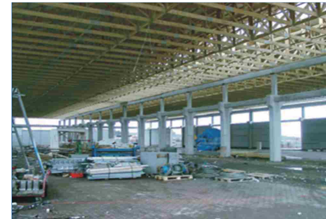
Ant betoninių kolonų sumontuotos medinės santvaros
