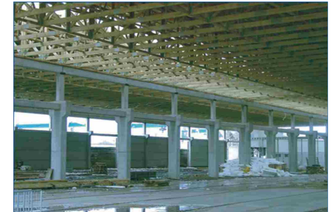
Ant betoninių kolonų sumontuotos medinės santvaros
